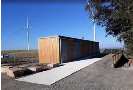
Illustration 129: Exemple de local technique (parc éolien de Flavin) (Source : EDPR)
